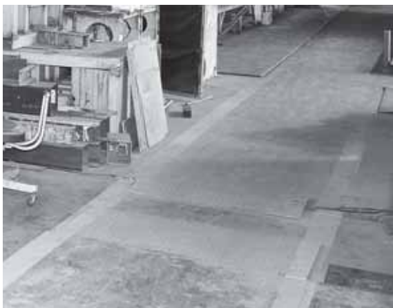
つまずき防止のため、段差解消板によるスロープを設置
