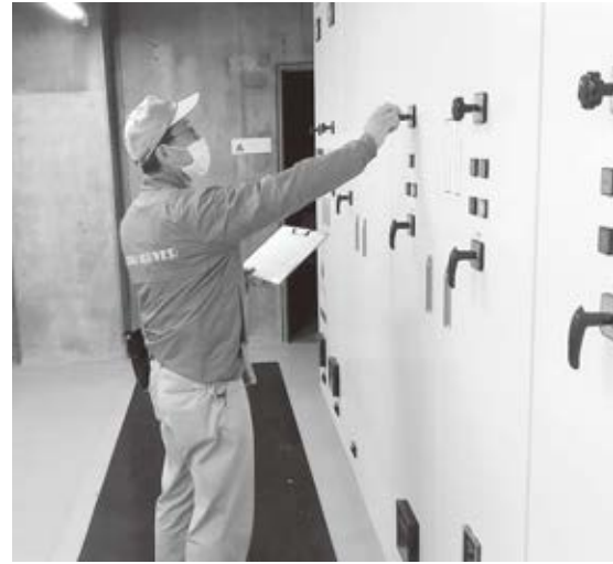
ビルの設備管理業務を行う高齢社員の様子
