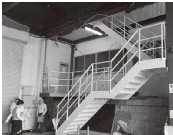
階段をらせん状から直線的な階段に替えて、安全性を向上
