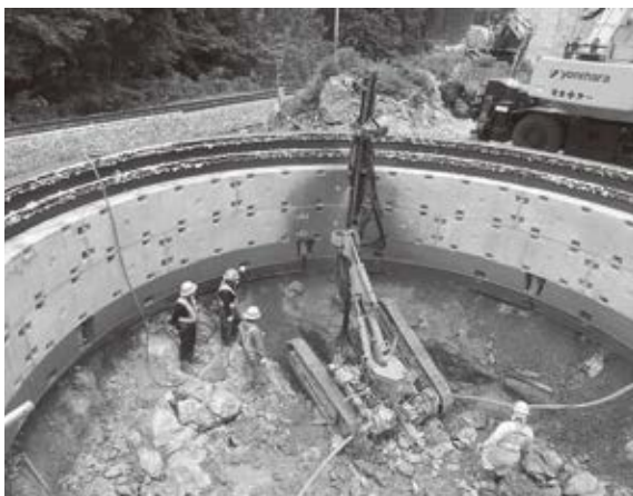
建物の重量を地中の支持層に伝達する杭を、地中深くに施工する大口径深礎工法
