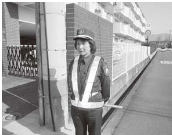
道路工事の誘導現場で職長として活躍するMさん
