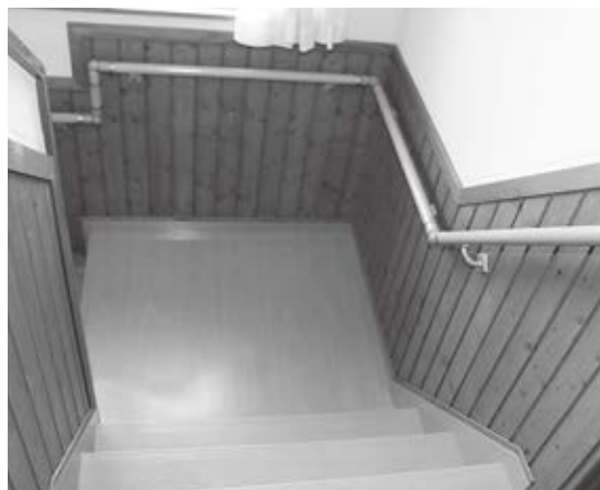
社内の階段には手すりを設置するなど環境改善にも努めている
