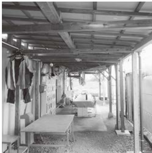
作業場の通路。高齢従業員が屋根の製作・修繕を行っている
