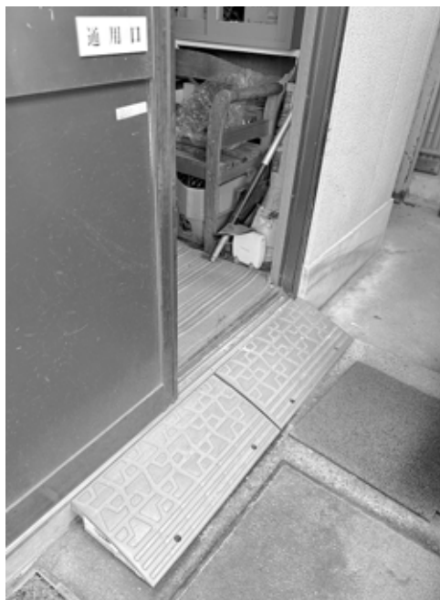
入口に段差をなくすスロープを設置
