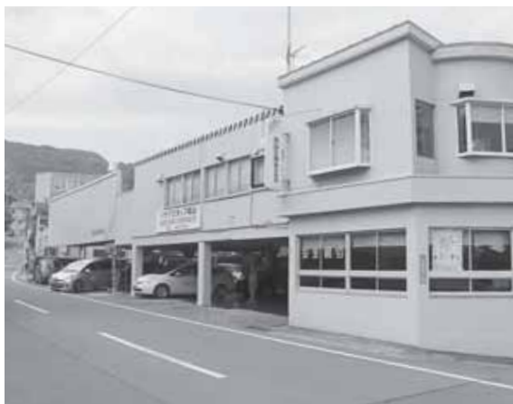
城山交通の本社全景
