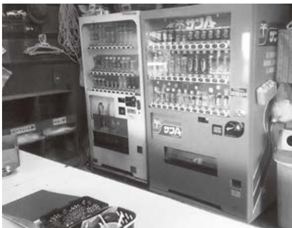
熱中症予防対策として休憩室内に自販機を設置
